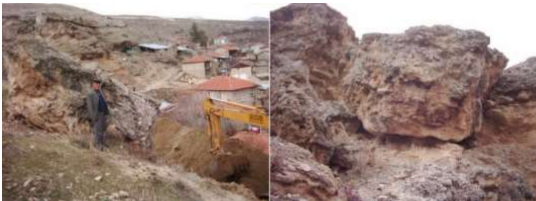
Resim 2.2 Burdur Merkez Yakaköy (Kurna) Köyü Kaya Islah Çalışması.
