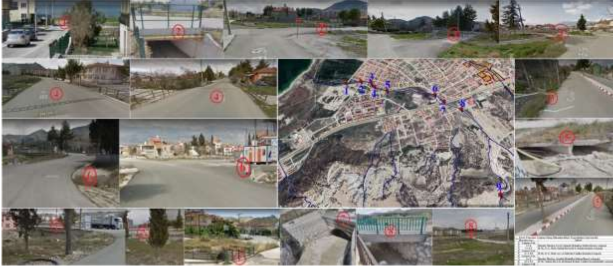
Şekil 2.53 Burdur Merkezde ve Fevzi Çakmak Mahallesi’nde bulunan Sultan Deresinde, işaretlenmiş lokasyonlardaki yol geçiş menfezleri.
